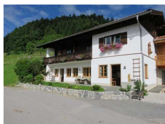
Außenansicht vom Koglhof
