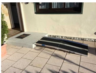
Rampe zum Eingang
