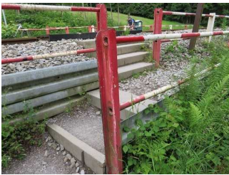
Stufen nach dem Übergang
