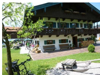
Seitenansicht vom ganzen Gebäude.
