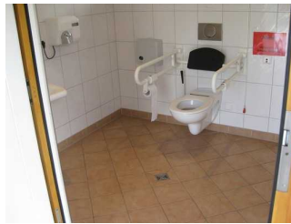
Blick auf die Ausstattung im Öffentlichen Behinderten-WC.
