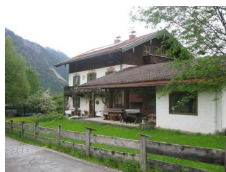
Blick auf den Vordereingang.
