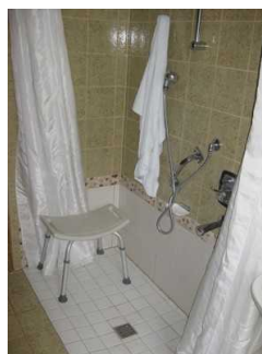
Wc im Sanitärraum.
