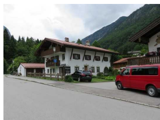
Außenansicht vom Gebäude
