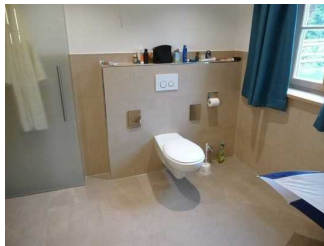
WC mit Aufnahmeplatten für Haltegriffe.
