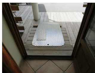
Mobile Rampe vor dem Eingang
