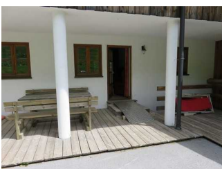
Eingang über die Terrasse
