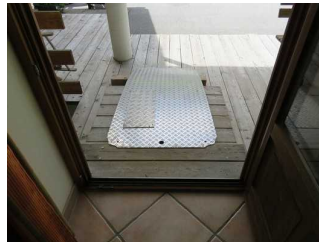
Mobile Rampe vor dem Eingang
