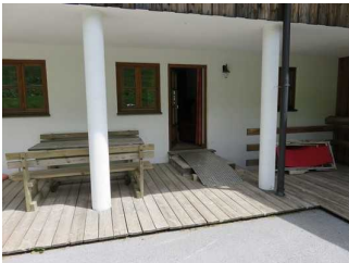
Eingang über die Terrasse
