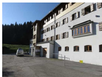
Ansicht von außen
