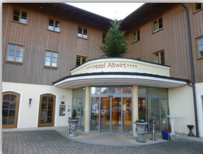
Außenansicht Hotel und Landgasthof Altwirt
