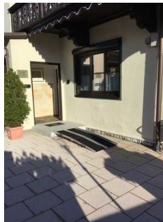
Weg zwischen Parkplatz und Stufe sowie Rampe zum Eingang
