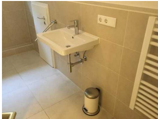
TG: Sauna - Sanitärbereich
