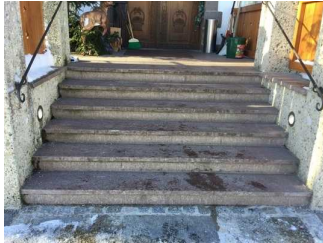
Haupthaus: Treppe zum Eingang
