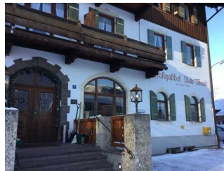
Haupthaus: Eingangsbereich Haupteingang
