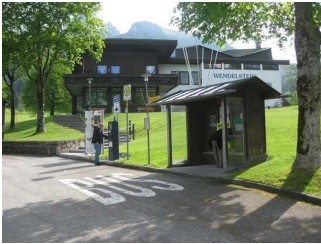
Bushaltestelle an der Wendelsteinbahn.
