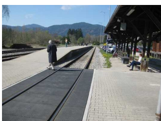
Überquerung zu den Gleisen.
