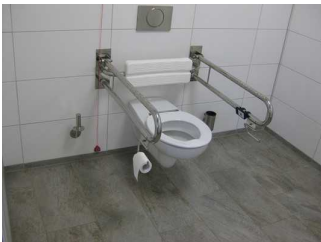
Zu sehen ist das WC und die Haltegriffe.
