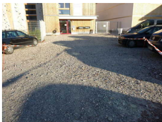
Unbefestigter Weg zum Eingang
