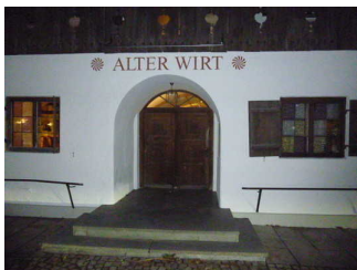
Treppe am Eingang
