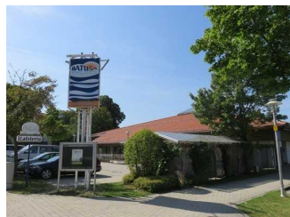
Außenansicht vom Gebäude
