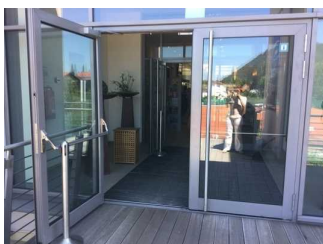
Tür zum Eingang über Treppe (Zentralebene)
