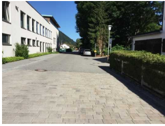
Weg zwischen Parkplatz und Eingang über Treppe
