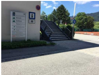
Weg zwischen Parkplatz und Eingang über Treppe
