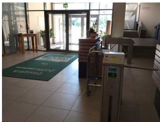
Ebene Haupteingang: Weg zwischen Kasse und Drehkreuz sowie Durchlass
