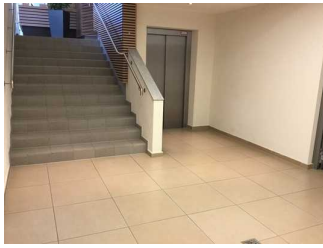
Treppe zwischen Seeebene und Ebene Haupteingang (Kasse)
