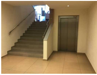
Treppe zwischen Seeebene und Ebene Haupteingang (Kasse)
