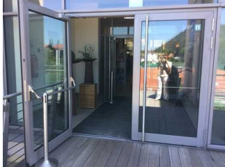
Tür zum Eingang über Treppe (Zentralebene)
