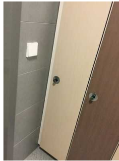
Türgriff Umkleide/ Duschraum/ öffentliches WC
