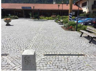
Weg zwischen Parkplatz und Treppe sowie Rampe
