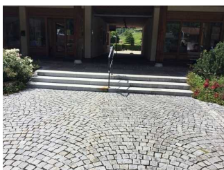
Treppe zwischen Parkplatz und Eingang
