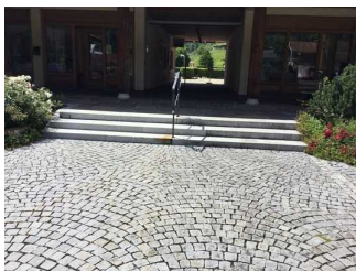
Treppe zwischen Parkplatz und Eingang
